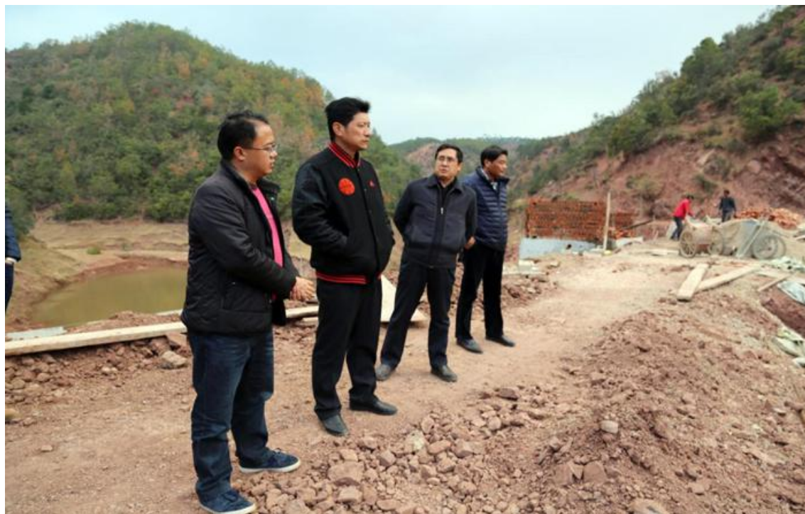
实地查看冷水箐水库除险加固工程现场
